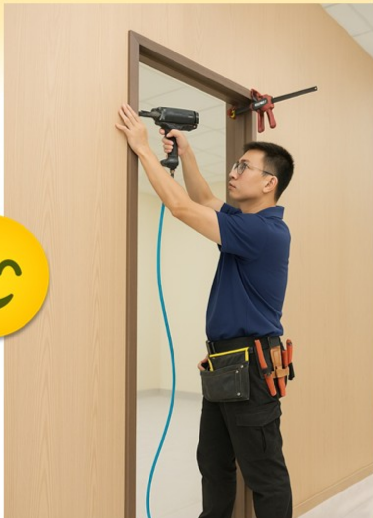
KD後裝式施工
