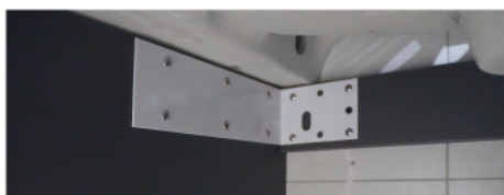
L鐵片固定 • 加強穩定度
